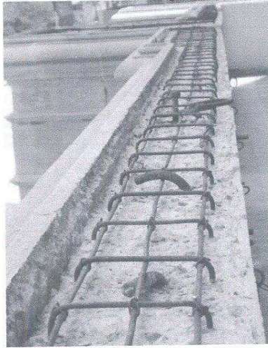
Colación de la formaleta de para preceder a la fundición del mismo
