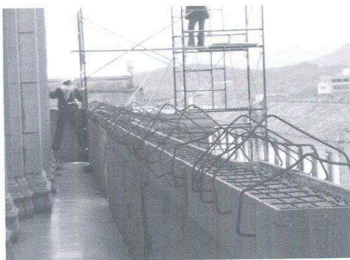
Formaleta finalizada y preparación de los elementos para la fundición
