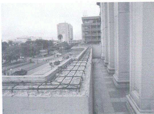
Forma en que quedó colocado todo el refuerzo de acero En el Balcón del Salón de Banquetes
