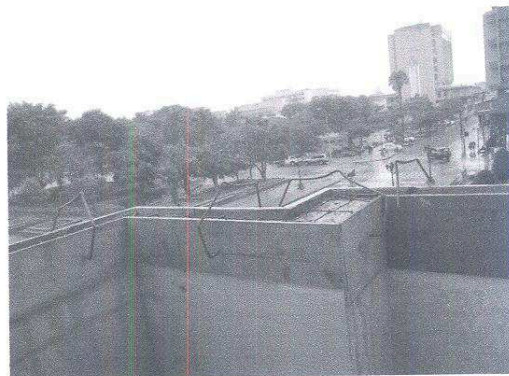
Formaleta lista para proceder a la fundición
