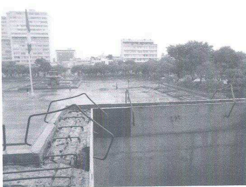
Formaleta lista para proceder a la fundición
